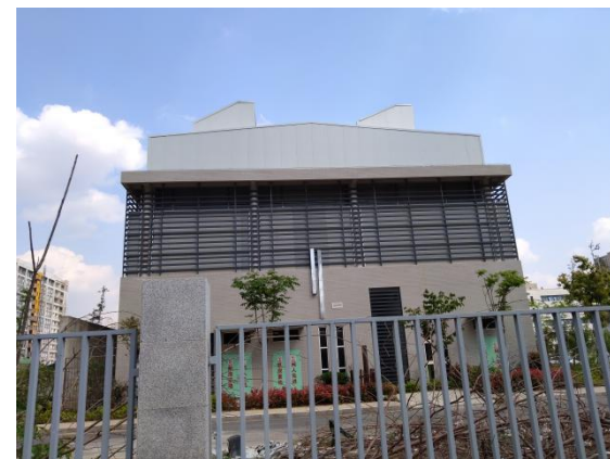
冷却塔隔声板和消声器
